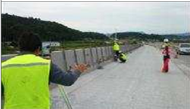
3. 레일 거치대 및 레일 설치
