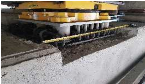
5. 신규 교량받침 설치
