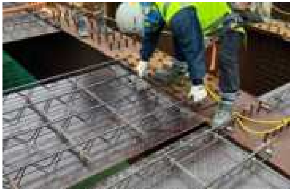
3. TG 합판패널 설치
