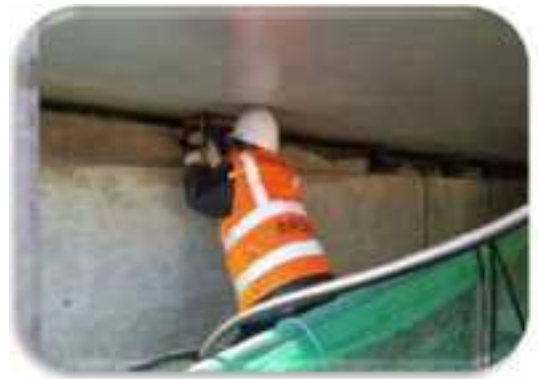
4. 변위 센서 설치
