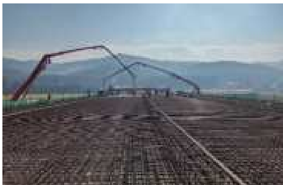
5. 슬래브 배근 및 타설
